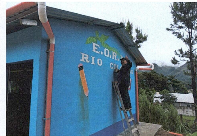
Foto 8: ACERA EXTERIOR DE AULA TIPO PORTICO
